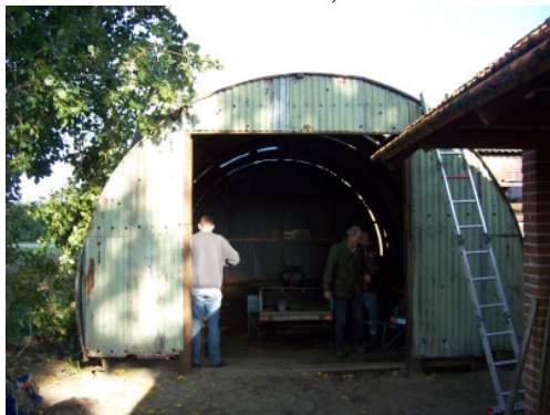
Onze loods in aanbouw
